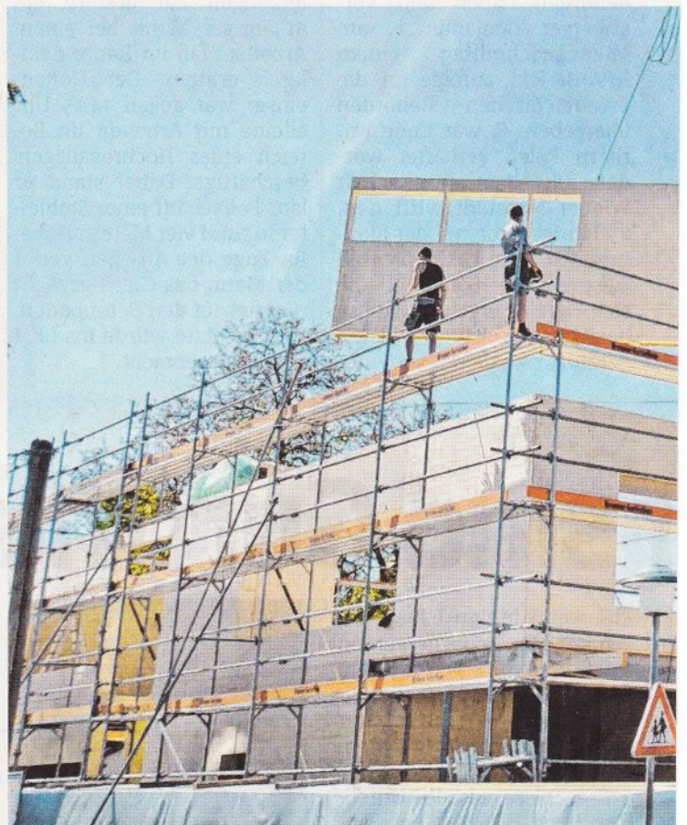
Die Holz-Fertigelemente werden fachkundig zum neuen Fußacher Kinderhaus in
